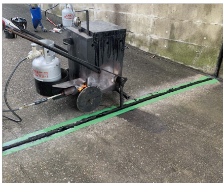
7 目地材注入工
