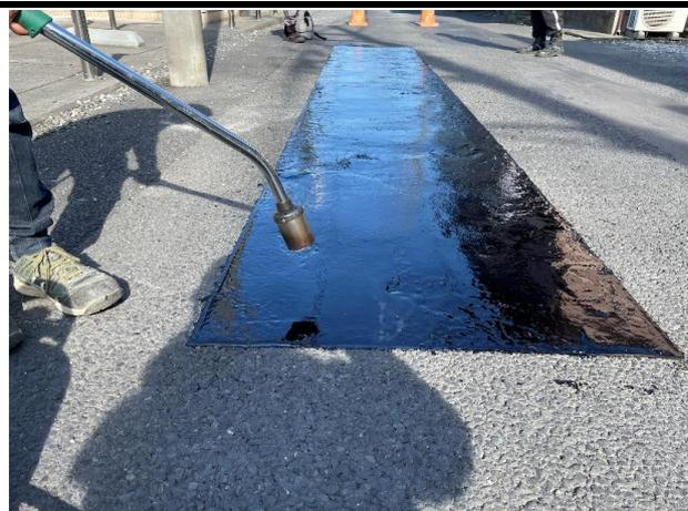
10. ハーナー炙り 養生テープを剥がした後、端部や表面をバーナーで焦がさないように炙り、成形します。
