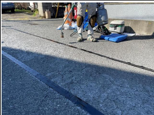
7. クイックシール貼り付け V/Uカットした内側にクイックシール貼り付けた後、白い離形紙を剥がしてバーナーで炙ります。
