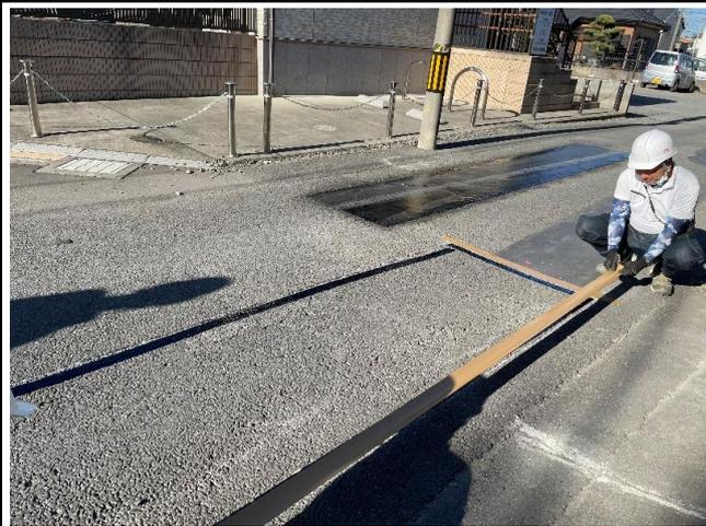
8. 養生テープ貼付け V/Uカットした外側に75mm以上の幅の養生テープを貼り付ける
