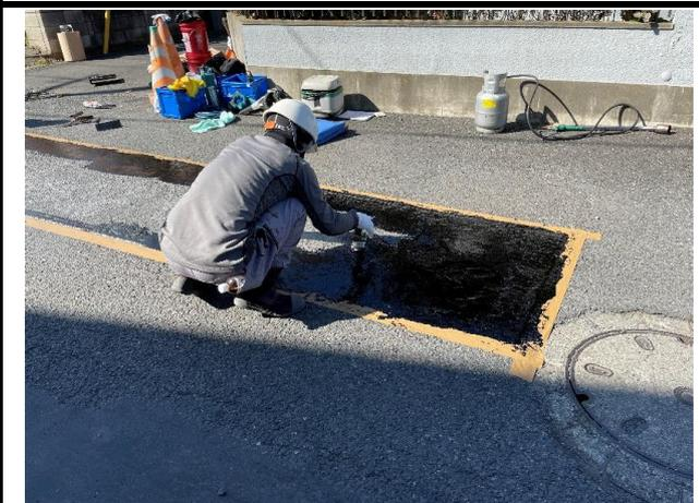
9. マスチックワン敷き均し マスチックワン溶解温度190°C~204°C確認後金属バケツに底から2杯、表面を1杯をいれ、充填し、熱コテで敷き均す。
