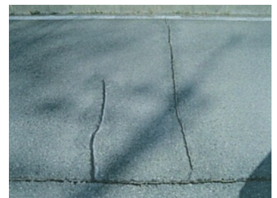
ひび割れをカットした状況
