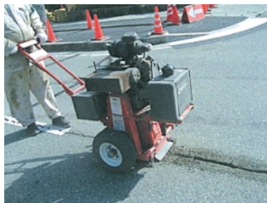
ひび割れを専用カッターで切削
