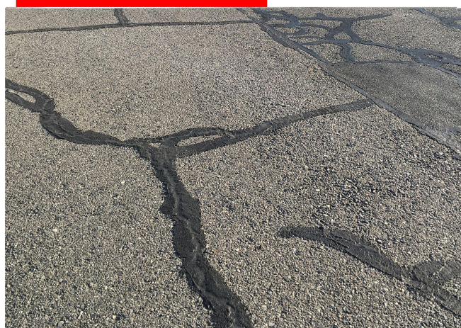
スーパーフレックス施工事例
