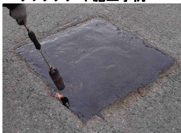
マスチックワン・ポリパッチ施工事例
